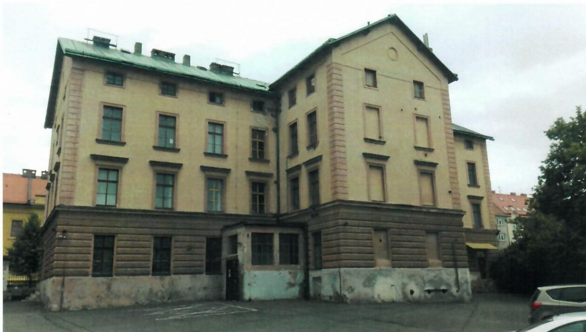
Budova Ústřední hudby před rekonstrukcí
