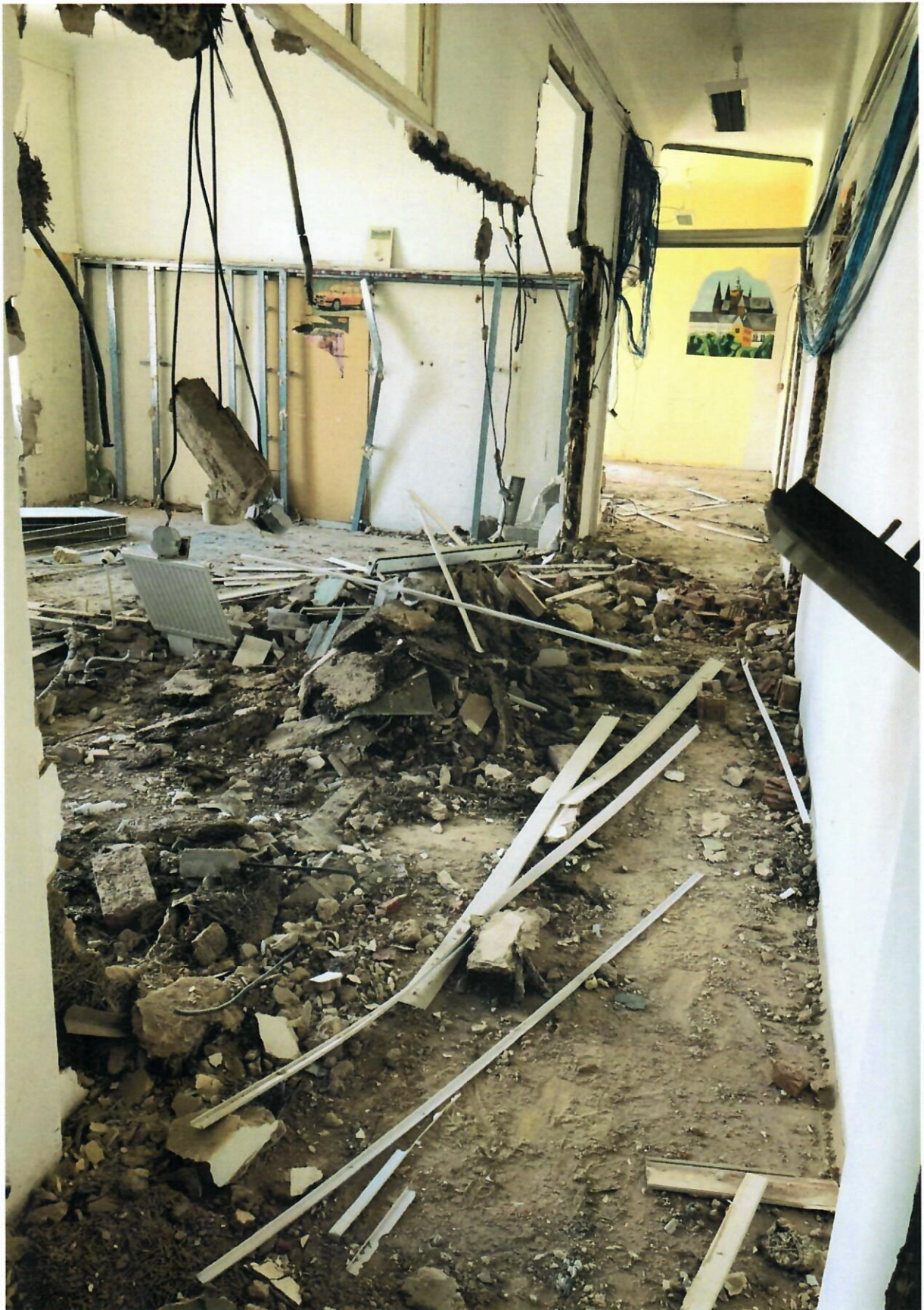
Bourací práce uvnitř budovy byly zahájeny
